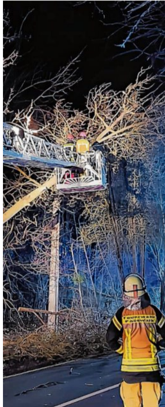
In der Waldeshöher Straße war ein Baum in eine Stromleitung gekippt. FOTO: FEUERWEHR JATZNICK
