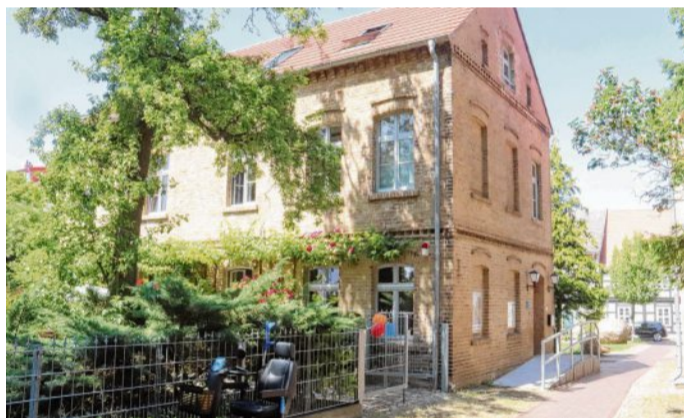
Das alte Gemeindehaus in Strasburg war über Jahre kaum mehr als eine Ruine. Die Zeiten sind nun vorbei.
