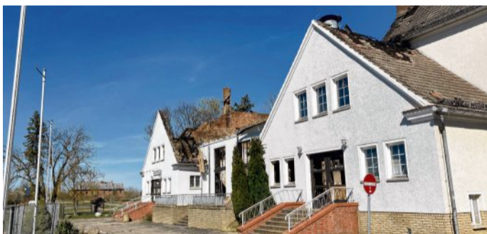
Das Kulturhaus in Strasburg soll wieder aufgebaut werden. Doch das wird noch dauern. FOTO: NK-ARCHIV
